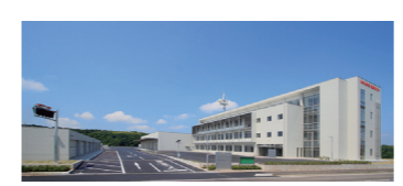
平成27年10月に統合した那須地区消防本部の庁舎(大田原市中田原)
