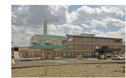
那須塩原クリーンセンター
