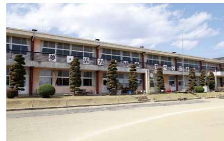
今年度設計を行い、26年度建て替え予定の西那須野中学校
