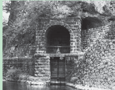
那須疏水西岩崎取入口
