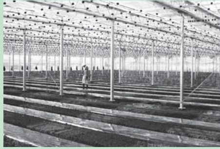
トマト栽培用鉄骨ハウス内部
