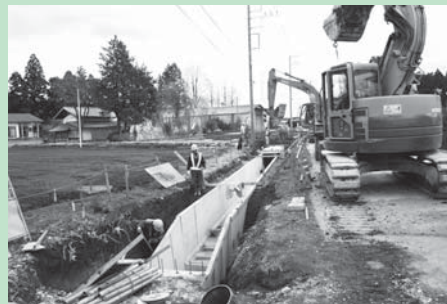
農業用排水路整備工事
