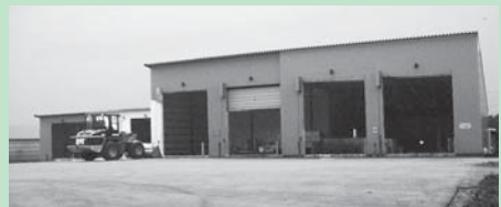
循環型社会を目指す堆肥センター製造堆肥の販売も行っています
