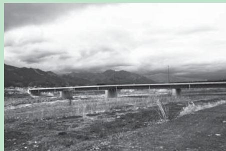
金沢・高阿津農道(橋りょう部)
