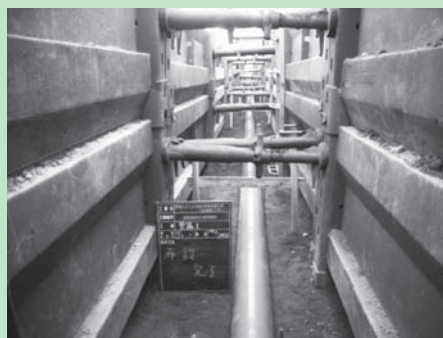
汚水管整備(特環)
