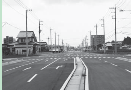
北土地区画整理地内の道路
