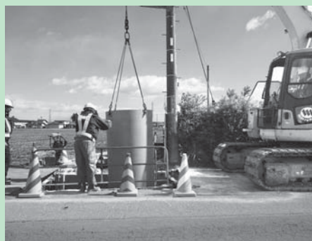
汚水管整備(公共)
