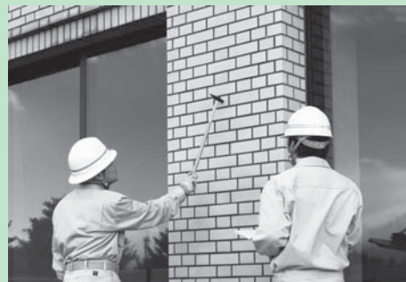
市有建築物定期点検
