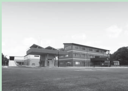
那須塩原クリーンセンター
