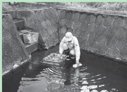
定期的に水質調査・分析を実施
