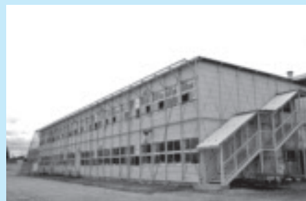
三島中学校仮設校舎
