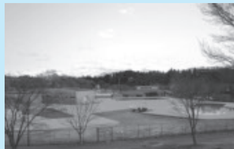
那珂川河畔公園プールがリニューアルオープンします
