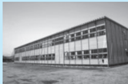
黒磯小学校仮設校舎
