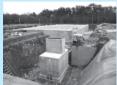
千本松浄水場高区配水池築造工事
