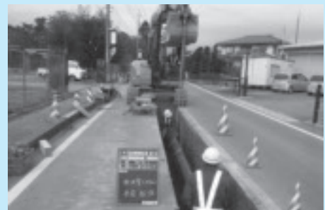
水道管整備工事
