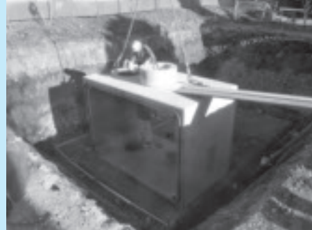
防火水槽設置工事の様子
