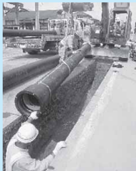
水道管整備工事の様子
