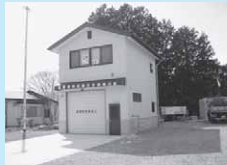
消防コミュニティセンター
