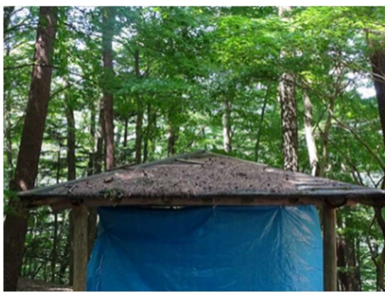
屋根の確認（劣化・塗装）
