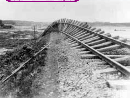
十勝岳の大正15年の噴火で発生した融雪型泥流によりねじ曲げられた線路の様子
