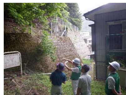
点検の様子（塩原地区内）
