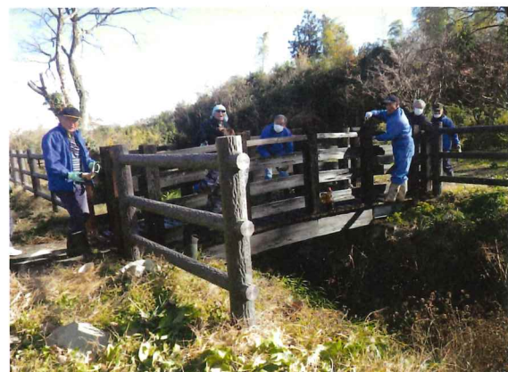
【津室川湧水地補修作業】
