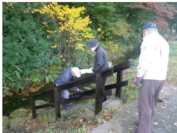
【乃木清水木階段補修作業】
