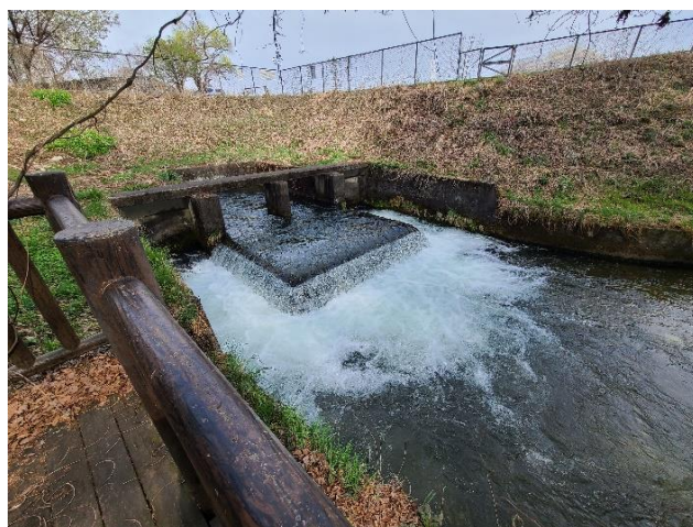
【那須疏水蛇尾川サイフォン出口】
