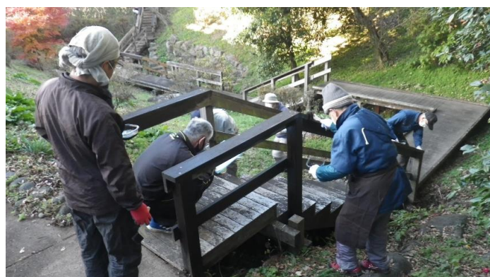
【塗装作業の様子】
