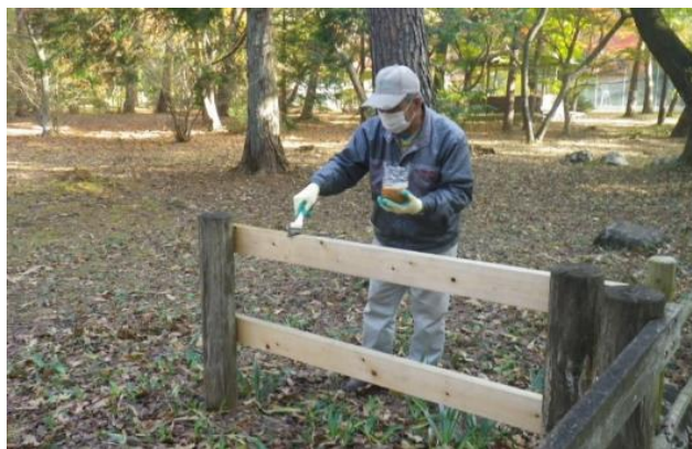
【塗装作業の様子】
