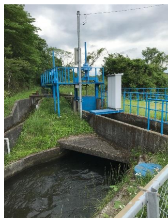
臺沼用水と那須疏水の立体交差 （横林）
