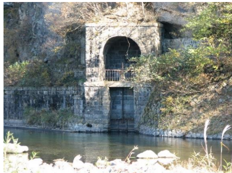
旧西岩崎取水口
