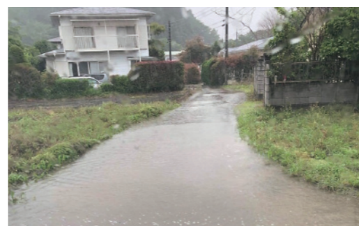
市管理道路砂利道の現状
