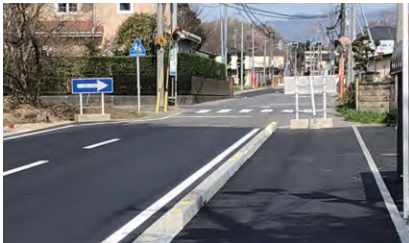
東原地区通学路整備
