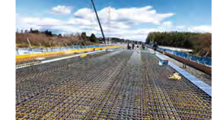
建設中の新南下中野線の橋
