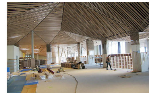
完成が近い図書館の内部
