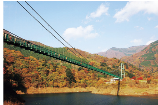
もみじ谷大吊橋
