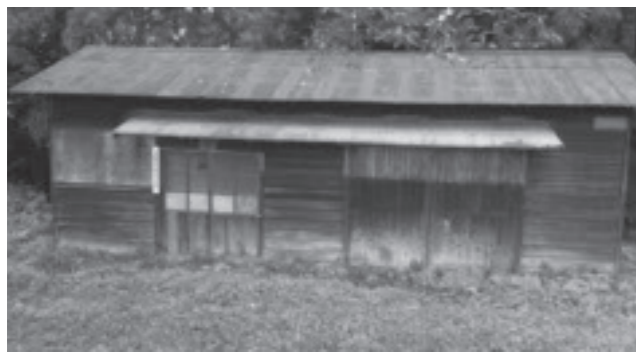
<黒磯水防倉庫>
