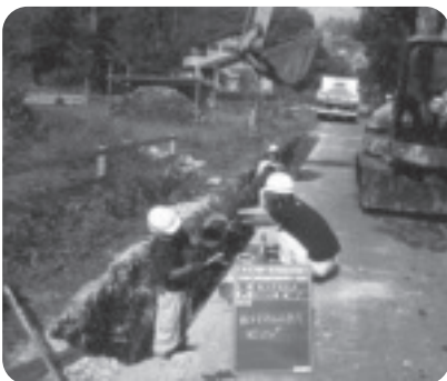
老朽管更新工事の様子
