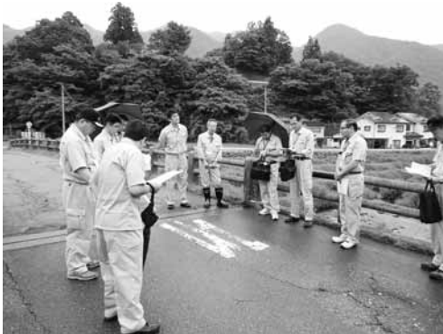
明神橋現況確認の様子
