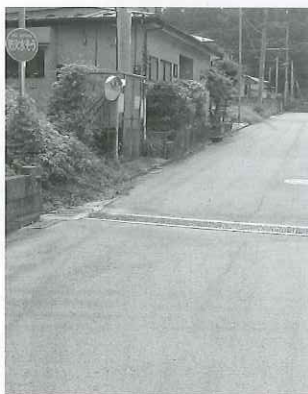
改善が望まれる雨水処理施設
