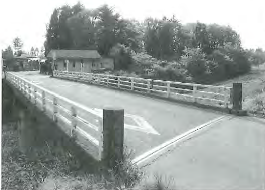
熊川に架かる学校橋
