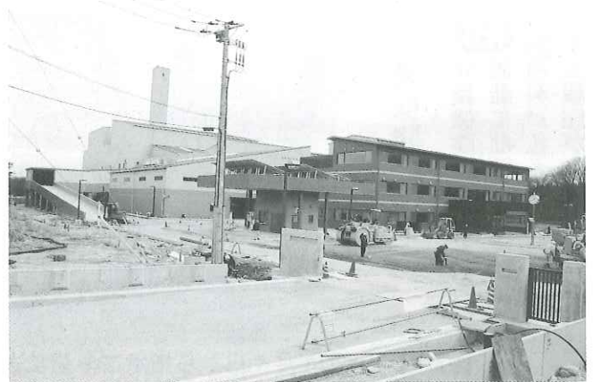
本年4月に供用開始となる那須塩原クリーンセンター
