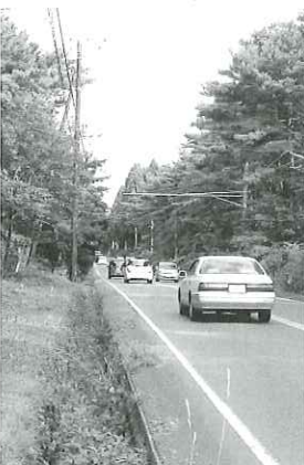
土側溝が続く国道400号
