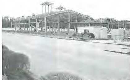
今年7月のオープンに向け工事が進む(仮称)那須ガーデンアウトレット
