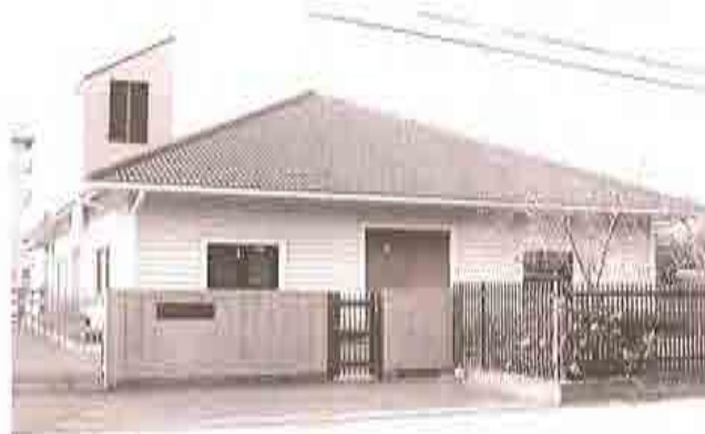
南赤田地区浄化センター
