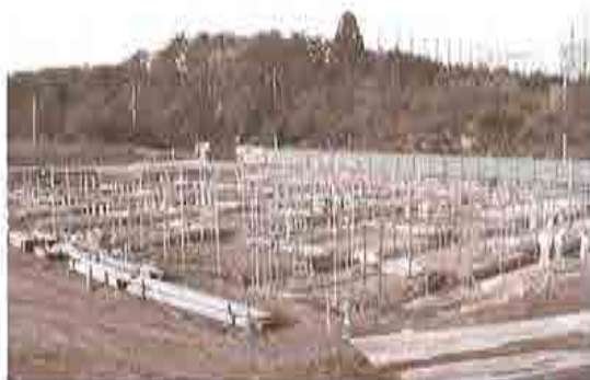
基礎工事が進められている現地
