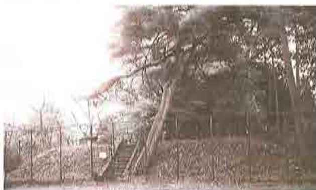
鳥ヶ森神社裏にある配水池の現況
