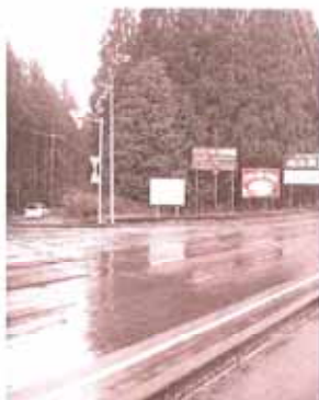
案内看板が立ち並ぶ上郷屋工業団地入口付近の様子
