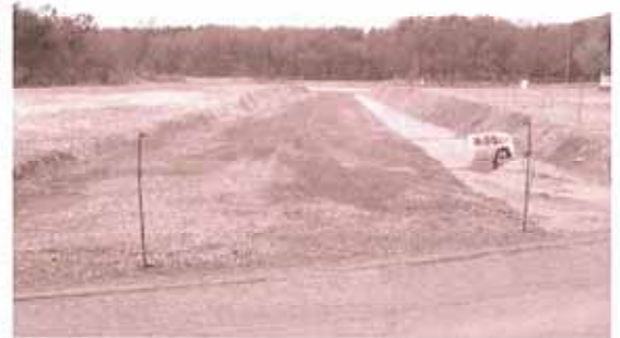
本格的な工事を前に造成がほぼ完了した用地
