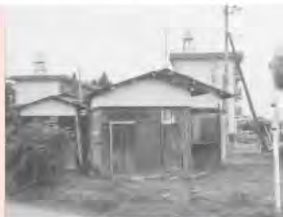
空き家となった市営住宅
