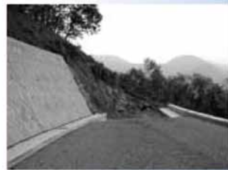
整備中の旧新湯線
