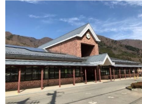
図2-9 市役所塩原庁舎の太陽光発電
