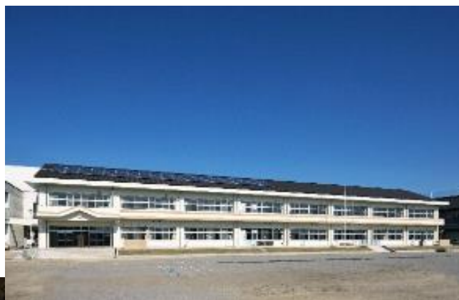
屋根に太陽光発電設備を設置した 西那須野中学校(平成26年度改築)
