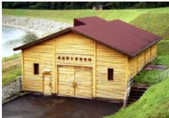
小水力発電(那須野ヶ原土地改良区連合HP)
