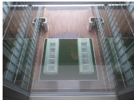
自然採光の利用 (栃木県佐野市役所)
