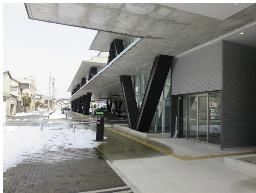
制振構造 (富山県黒部市役所)
