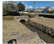
地場産石材が使われる農耕地を支える那須疏水
