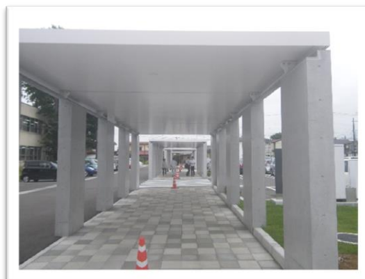
屋根付の通路（福島県須賀川市役所）
