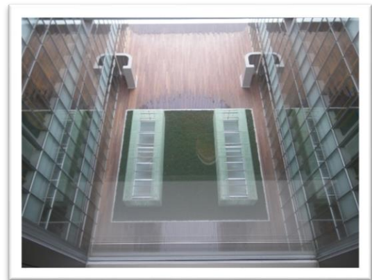
自然採光の利用（栃木県佐野市役所）
