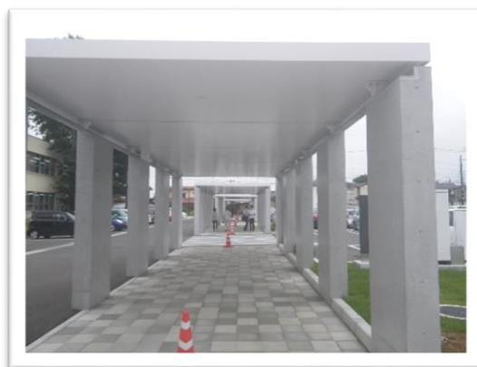
屋根付の通路（福島県須賀川市役所）
