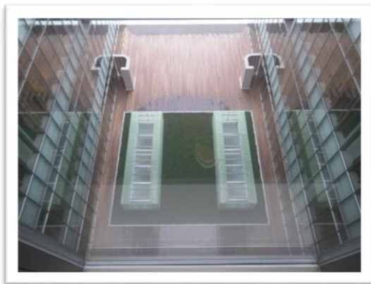
自然採光の利用（栃木県佐野市役所）
