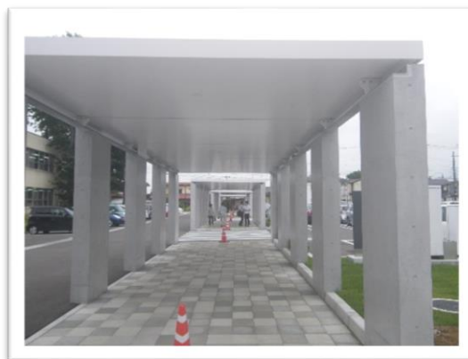
屋根付の通路（福島県須賀川市役所）
