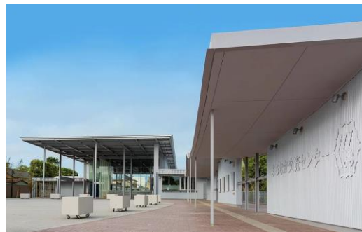
那須塩原市まちなか交流センターくるる(令和元年7月開館)
