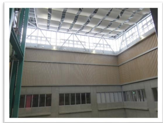
自然採光の利用（富山県射水市役所）
