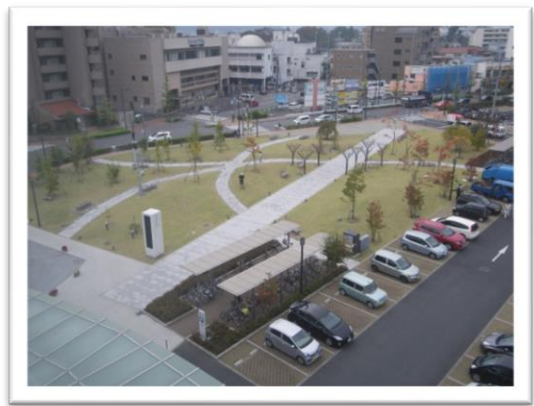
緑地と関係した庁舎（東京都青梅市役所）
