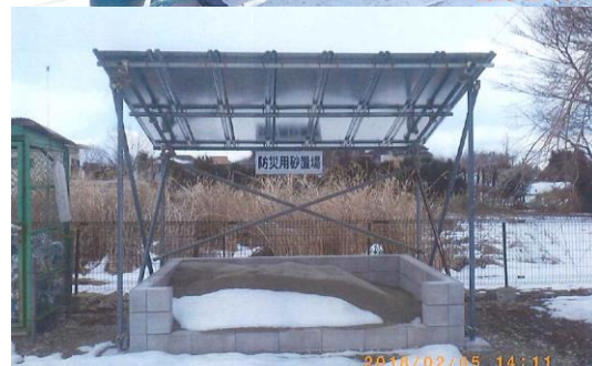
【↑防災倉庫と砂置き場】
