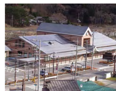
市役所庁舎や学校の校舎の屋根に設置している太陽光発電システム
