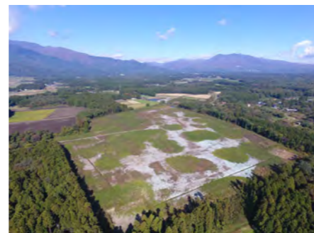
造成が進められている那須高林産業団地
