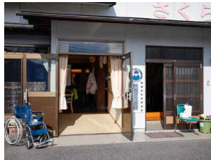
一般住宅の玄関を活かしつつ、スロープ付き玄関を新設。
