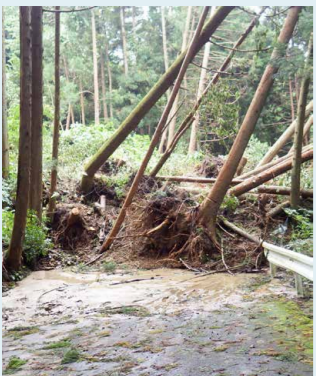
土砂崩れにより樹木が道をふさぐ塩原地区の様子
