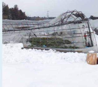
大雪により倒壊した農業用施設
