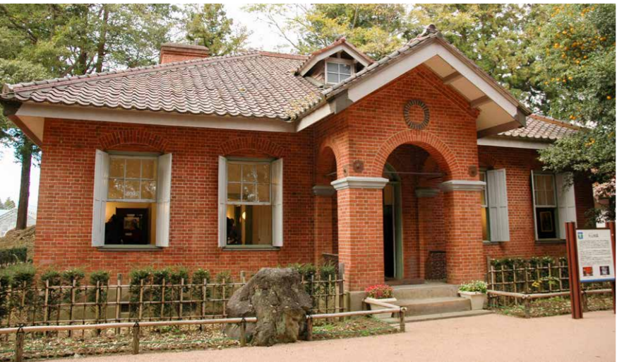
那須拓陽高校の敷地に建つ大山記念館。大山農場で焼いたレンガが、素朴で重厚な印象を醸し出している。
